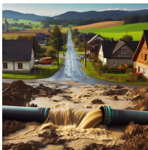
10. ábra: a csőtörés ma mindennapos valóság Sülysápon a vízközmű leromlott állapota miatt.
